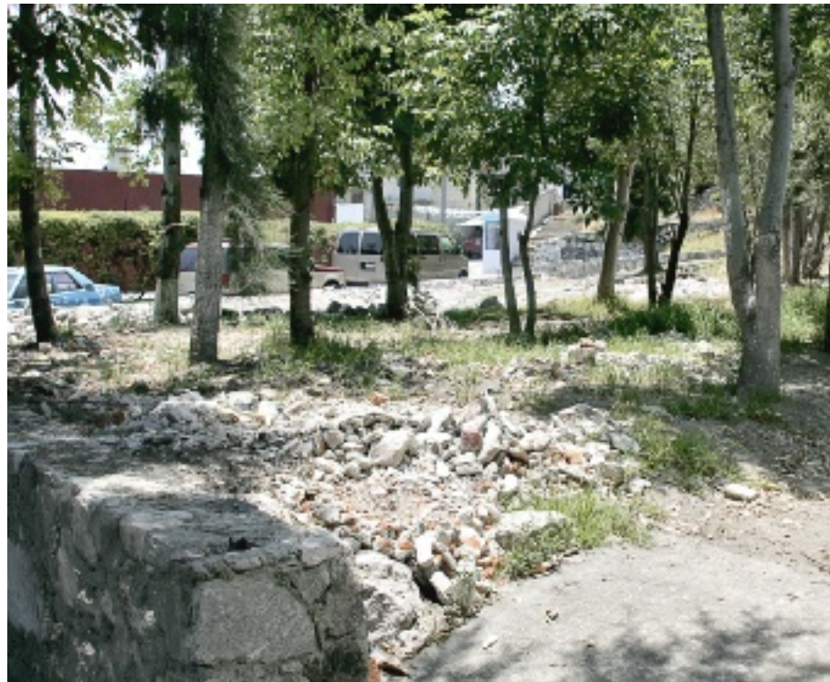
► El predio de la Calle de Córdoba luce invadido de material de construcción.
